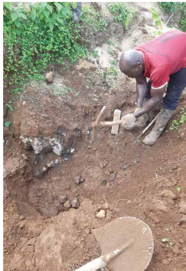
Ein Felsblock musste stellenweise abgetragen werden, um den Baugrund vorzubereiten.
